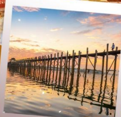
สะพานไม้จูปิง
